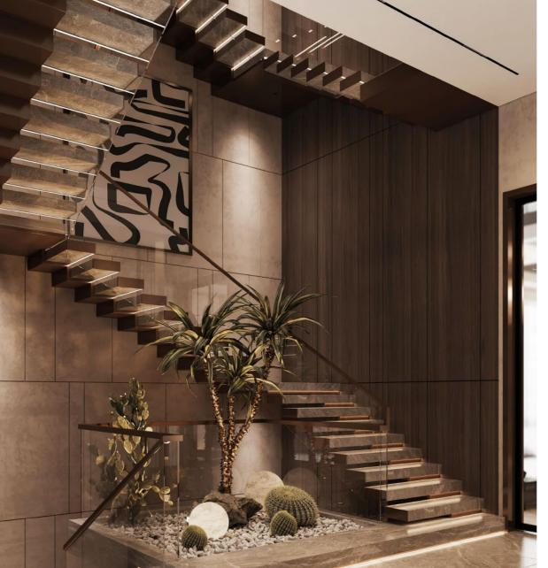
Projenin iç mekân sirkülasyon alanında konumlanan merdiven, taşıyıcı sistemden bağımsız olarak kurgulanmış olup, duvara ankrajlı çelik konstrüksiyon üzerine basamak montajı yapılmıştır. Basamak kaplamalarında yüksek dayanımlı doğal cilalı mermer kullanılmış, kenarlara entegre edilen LED şerit aydınlatmalar ile hem yönlendirme hem de görsel bütünlük sağlanmıştır.
