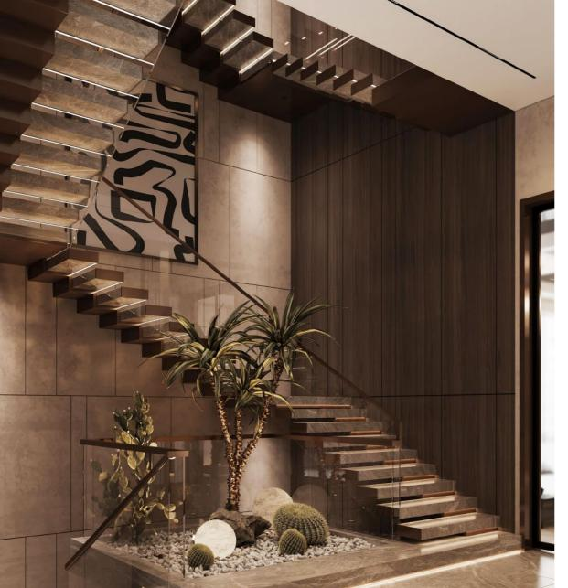
L'escalier, situé dans la zone de circulation intérieure du projet, a été conçu indépendamment du système porteur. Les marches sont installées sur une structure en acier ancrée au mur. Un marbre naturel poli, à haute résistance, a été utilisé pour le revêtement des marches, et des bandes LED intégrées sur les côtés assurent à la fois l'orientation et une cohérence visuelle.
